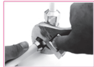
ثابت شدن لوله بین حلقه و ماسوره در اتصال دنده ای
