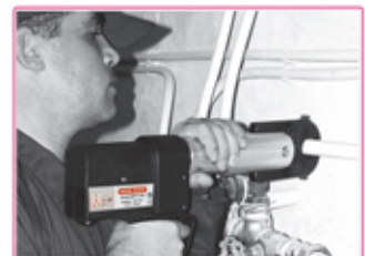
ثابت شدن لوله بین حلقه و ماسوره در اتصال پرسی
