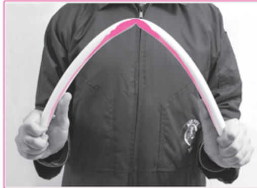
نحوه غیراصولی خم نمودن لوله با دست
